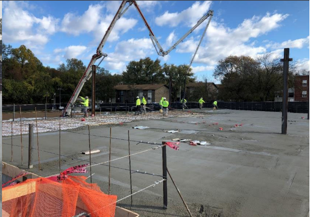
Wing B East – 2 nd Level Concrete Slab Pour
